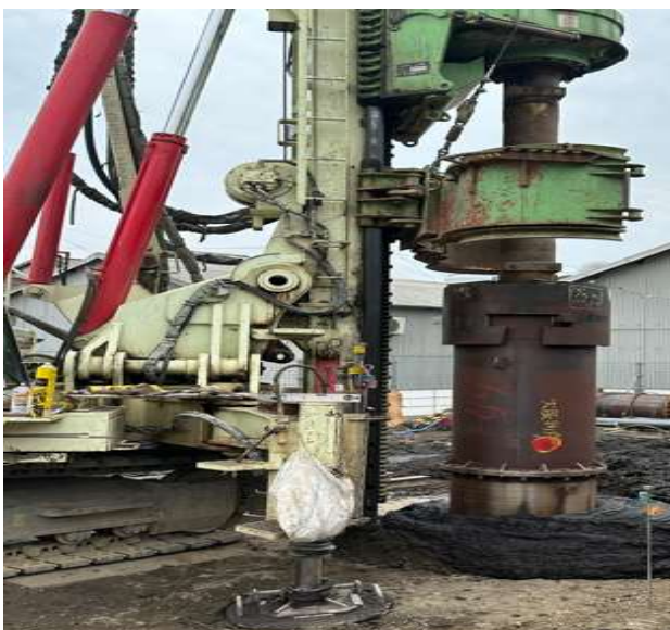
ケーシング埋設
